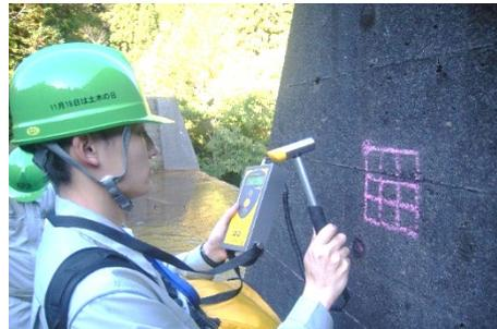
非破壊試験装置による老朽化調査
