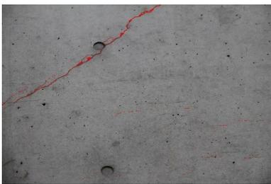
図-1 コンクリート壁面からのひび割れの検出
