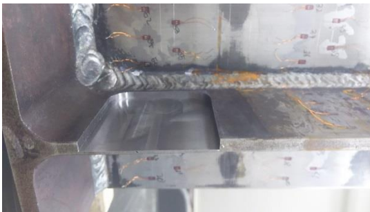
人工的な断面欠損を導入した鋼桁端試験体
