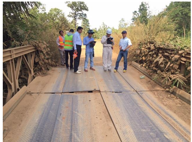
図 2 開発途上国におけるタブレット点検中の風景
