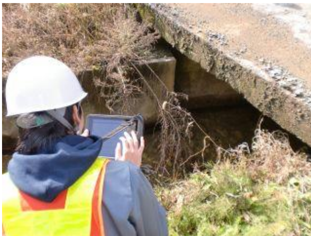
図 1 タブレット点検システムを用いた市町村管理の橋梁点検風景
