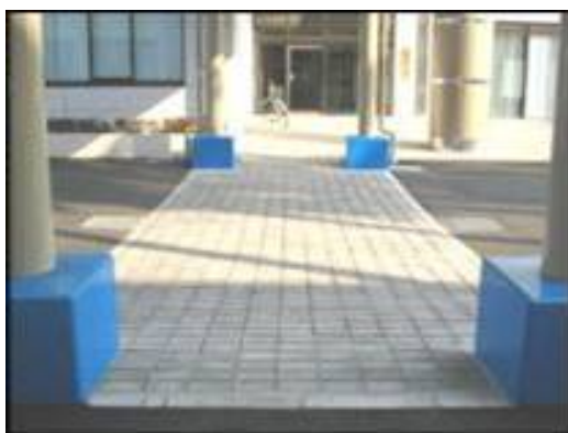
図1 車道部に敷設したインターロッキング
