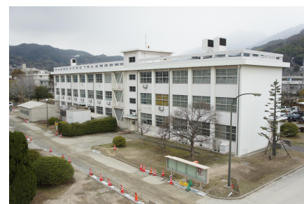
調査対象建築物全景
