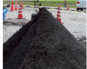
写真2 石膏系固材を用いた建設汚泥リサイクル
