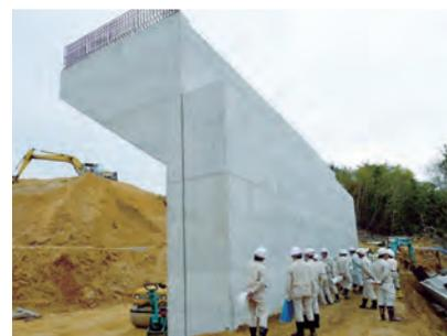
写真3 ひび割れ抑制に成功した壁式橋脚
