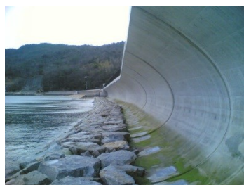
図-1 フレア型護岸
