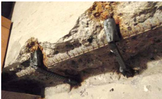
写真1 集合住宅梁の欠損改善計画・監理
