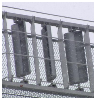
図2 地吹雪による視程障害対策用風車
