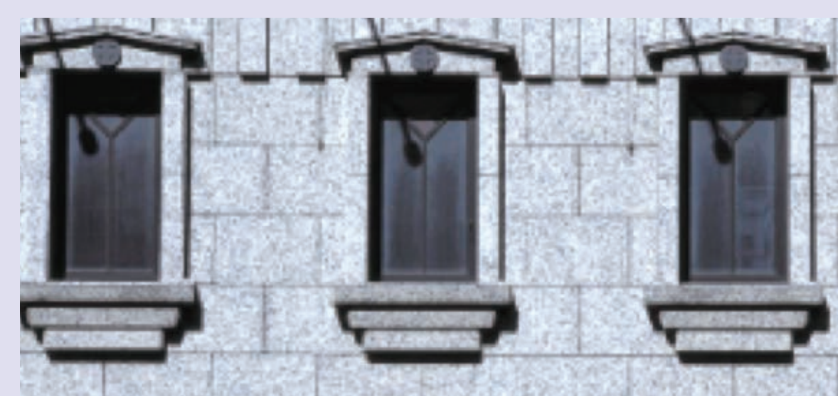
▲ビル外壁保護
