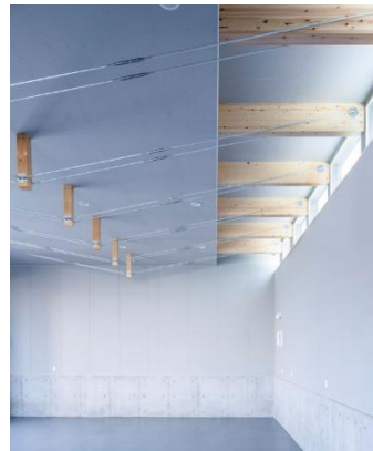
内装制限を意匠化した木造車庫 (千種の木造ビル・新築)
