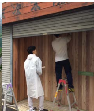
野波屋改修作業の学生
