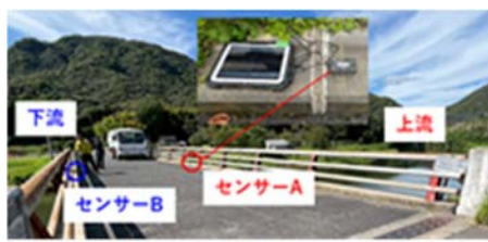
写真-1 橋梁のたわみ計測
