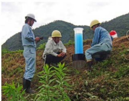
図-1 ため池堤体での計測状況
