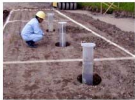
図-2 盛土施工途中での透水性管理状況
