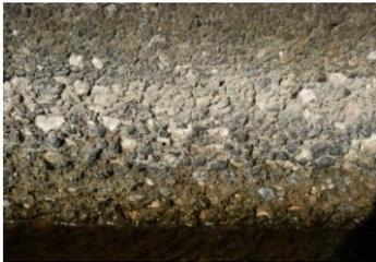
摩耗が進行して骨材が露出した水路
