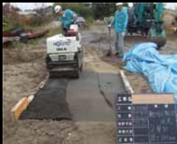
路盤の試験施工
