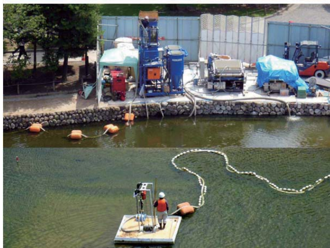
●写真1 国宝松本城内堀浚渫時の状況
