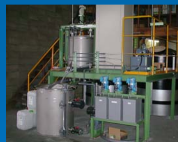
図3 環境浄化材料試作プラント
