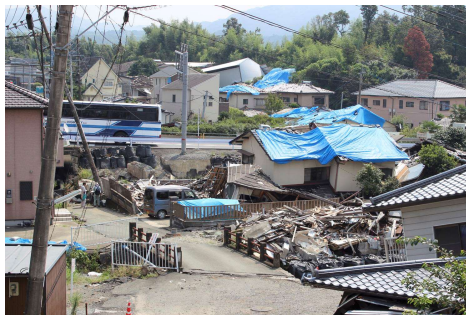
2016年熊本地震の建物被害 (益城町・2016年9月 澤撮影)
