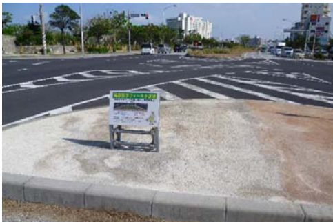
図-1 土系舗装の試験施工
